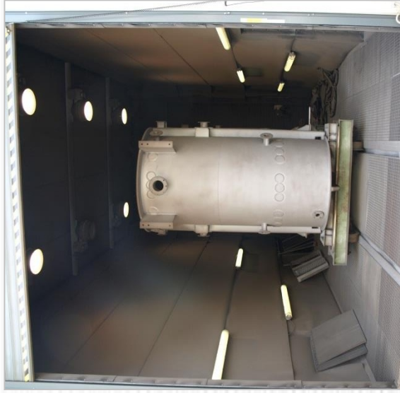
Kadź transformatora w kabine śrutowniczej
